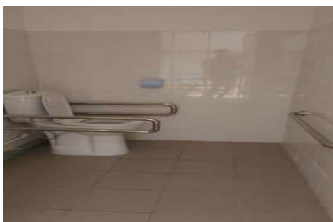
Оборудован специальный санузел
