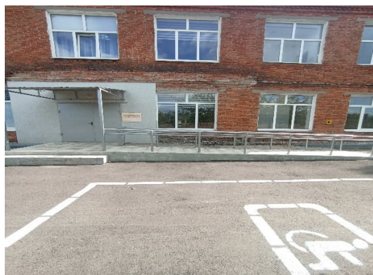
Вход в учреждение оборудован пандусом
